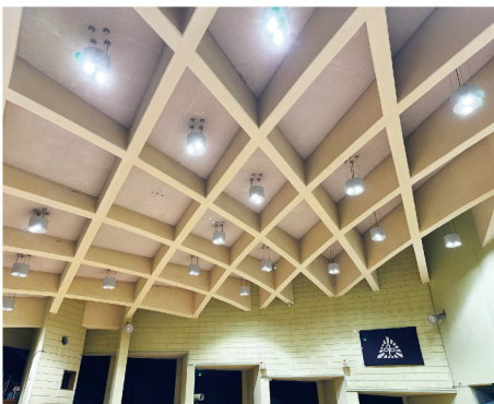
大ホールの梁は入れ方にも工夫が施され、下から見るとマス目状になっています。これは宮代町の特産品でもある巨峰のドウロを再現しているのだとか。
