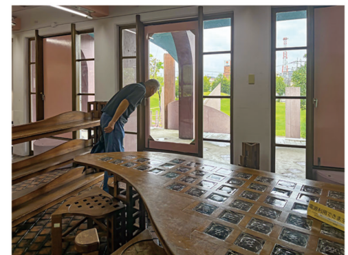
ロビー北側の木製だった回転窓の前で。一部はガラス戸に入れ替えられています。
