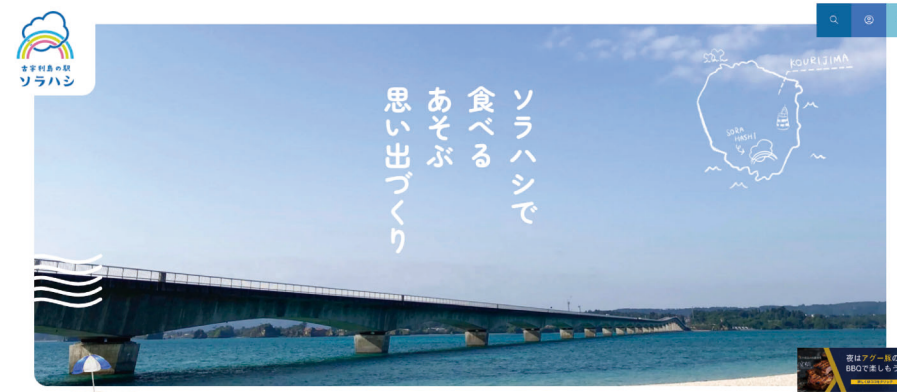
「古宇利島の駅 ソラハシ」のウェブサイトには、沖縄屈指の絶景ポイント「古宇利大橋」が掲載されています。
