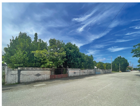
住宅地にはブロック塀に石張りを施し、連続性が出るようにしている箇所もあります。
