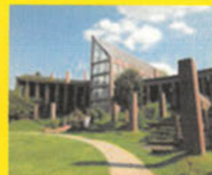
宮代町進修館 東武動物公園駅徒歩5分
